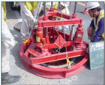
フレームリフターでマンホール鉄蓋受枠を撤去
