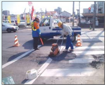
舗装切削までの間、仮復旧をおこなう。
