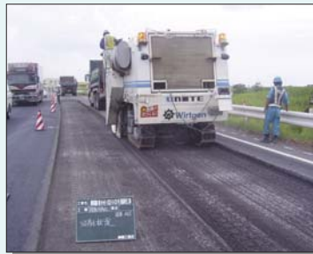
舗装内に障害物がないため、大型機械による連続施工が可能。
