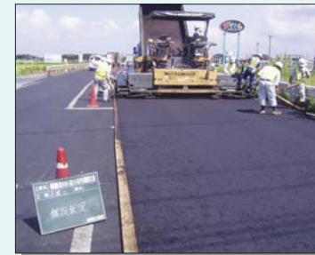
連続施工により、均一な品質が確保できる。
