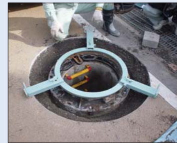
スパイダーを用いることによって、路面とマンホール鉄蓋受枠がフラットに仕上がる。
