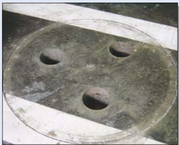
吊り金具取り付け部の舗装を除去。
