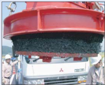
リフター吊り金具と仮蓋を連結し、引き上げ撤去。
