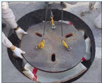
開口部清掃後、躯体及び調整リング上に仮蓋を設置
