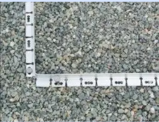
アルミエッジ施工事例
