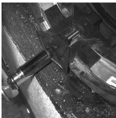
写真-8 ウエッジの締付け状況
