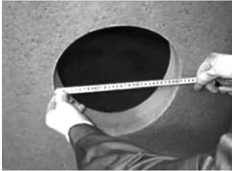
写真-5 穿孔径の確認
