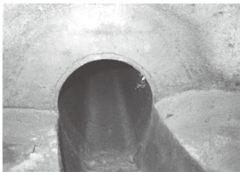
ブーツ トグルタイプ使用箇所 目地切れはあるが、流水機能は保持
