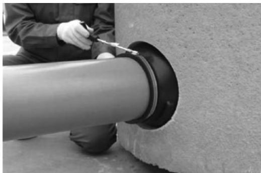
写真-11 外部バンド締付け状況
