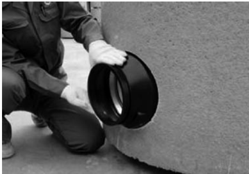
写真-7 ブーツ本体のセット状況
