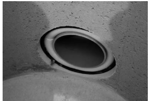
写真-13 O-リング装着状況
