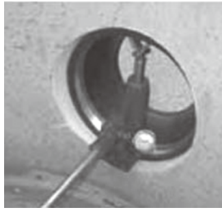
写真-3 油圧ジャッキによる拡張状況
