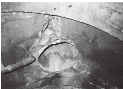
ブーツ トグルタイプ未使用箇所 防護コンクリート破壊、管路が突出して漏水発生
