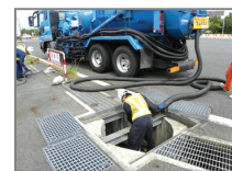
清掃作業の状況
