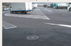
マンホール蓋 (T-25)
