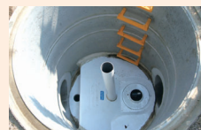
暗渠 (深い水路)
