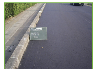
↑舗設(表層)完了 (舗装品質の向上と均一化)
