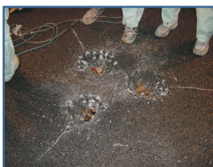
↑ 仮蓋穴位置×3箇所の舗装を撤去
