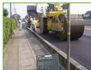
↑舗設(表層)状況 (機械施工の合理化)
