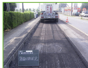
↑路面切削状況 (機械施工の合理化)
