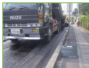
↑舗設(表層)状況 (連続した機械施工)
