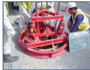
↑フレームリフターを使用してマンホール蓋の引き上げ
