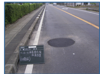
↑復旧材の舗設完了 (第一工程の完了)
