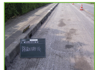
↑路面切削完了 (安全で円滑な交通状態の確保)
