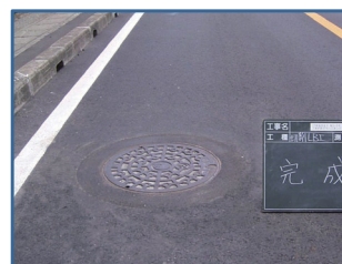
↑ 完了 (周辺路面とフラットな仕上がり)
