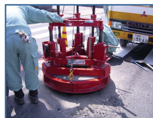
↑ 仮蓋+吊金具+フレームリフターを連結し、仮蓋の引上げ
