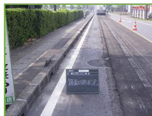
↑路面切削状況 (連続した機械施工)
