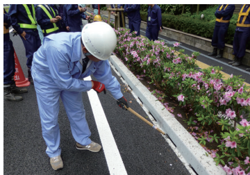
スリットの清掃は、工具を使用して行います。(※高压洗浄による清掃も可能)
