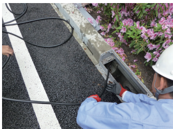
縁石柵から高压洗浄機で清掃します。
