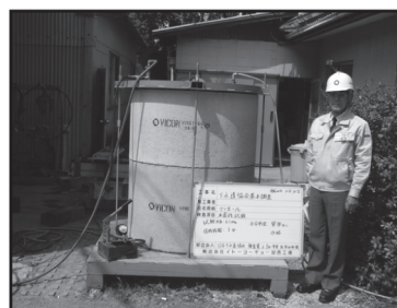
水密性試験 (1号マンホール 0.1 MPa・3分)
