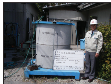
水密性試験 (1号マンホール 0.1 MPa・3分)
