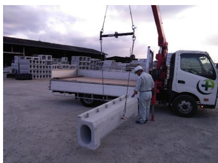
③吊り状況
