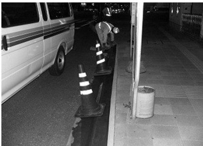
標準部でのシート養生状況
