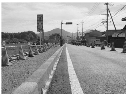
ライン導水ブロック-F型スリット部のガムテープでの養生状況
