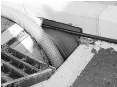
標準部車道枦での作業状況
