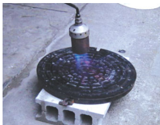
① マンホールふたを加熱
